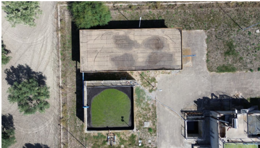
Figura 5: SITO N.5 – DEPURATORE
